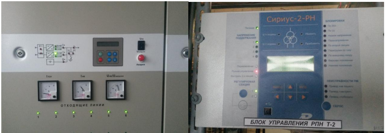
монтаж и наладка микропроцессорных защит.
