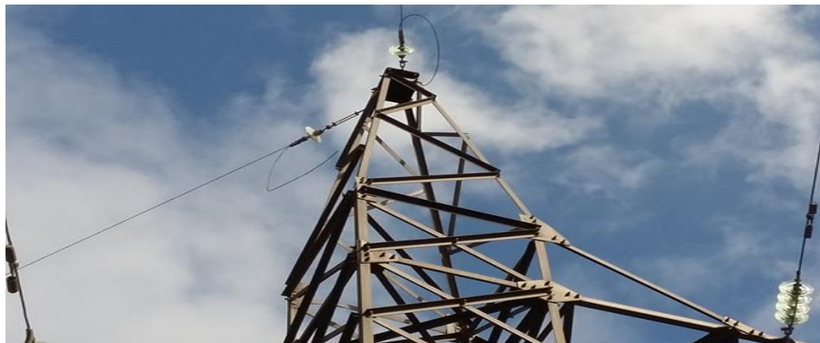
ПС 110/10 кВ “Уш-Биик”
